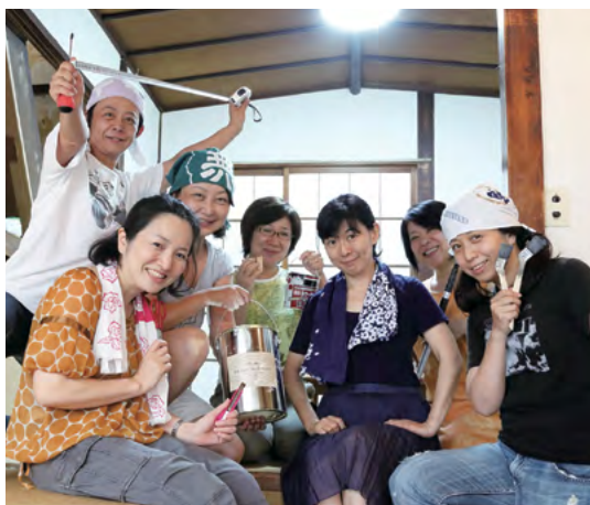
2014年「昭和な家1955」のリノベーション。みんなで壁塗り。
